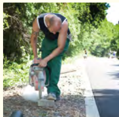
Arbeiten an der Nordbahntrasse
